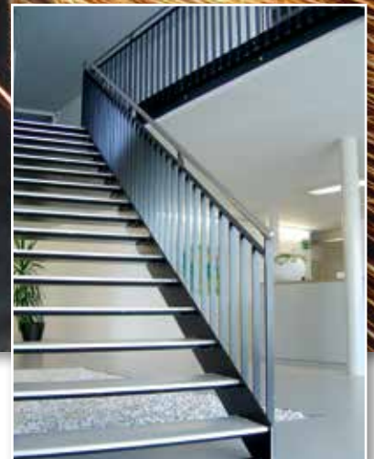
Metalltreppe und Geländer
