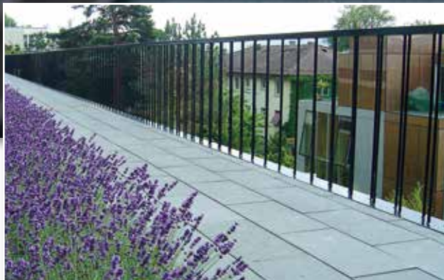
Metallgeländer in Stahl, feuerverzinkt, beschichtet
