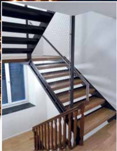
Hotel Splendid, Zürich: Treppe mit Web-Net Geländersystem
