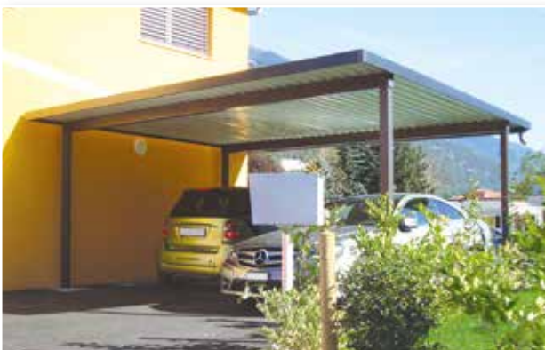
Carport freistehend mit Trapezblech-Dacheindeckung
