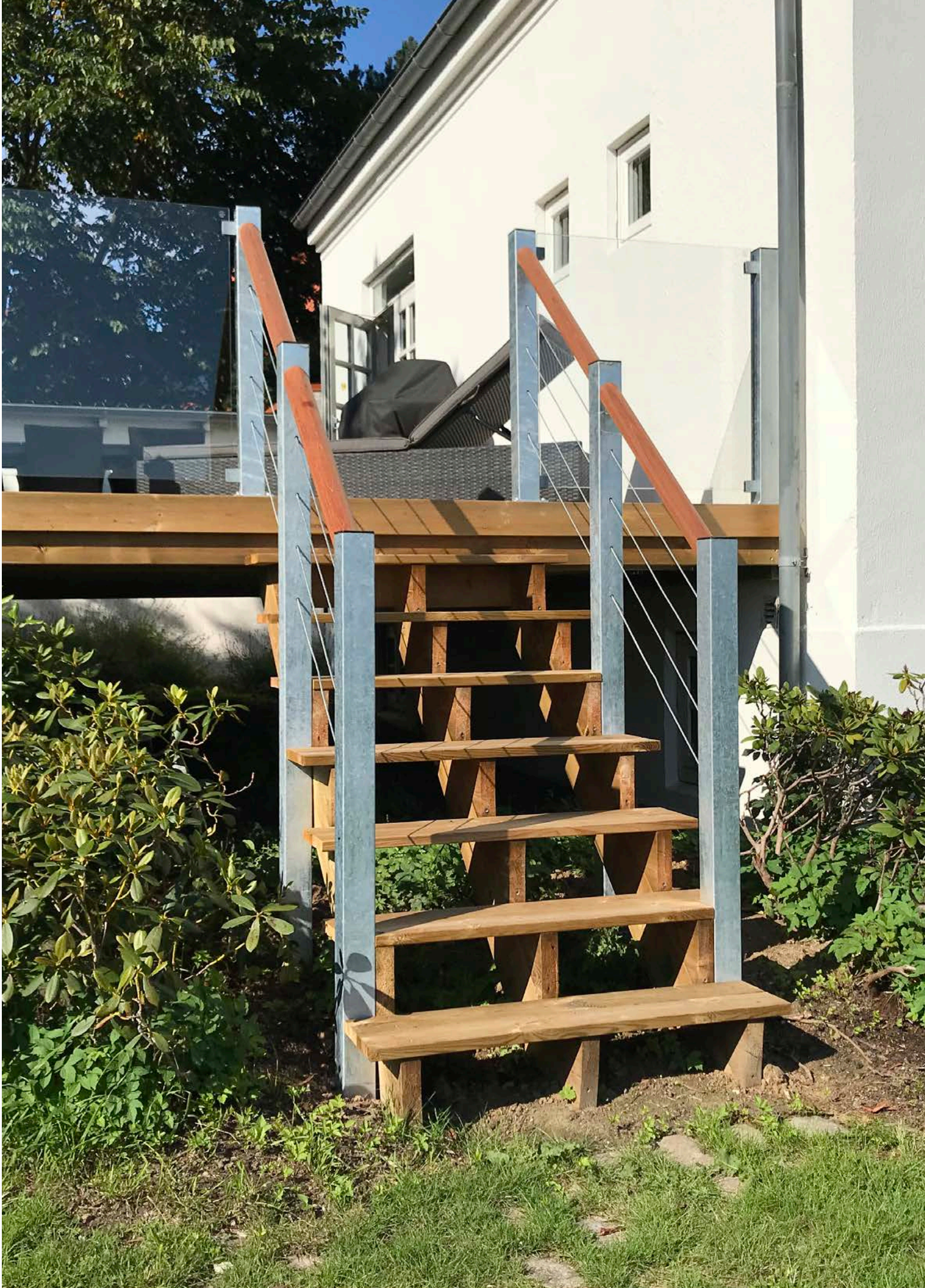
Treppenwangen – 7-Stufen in druckimprägniert mit Holzbrettern
