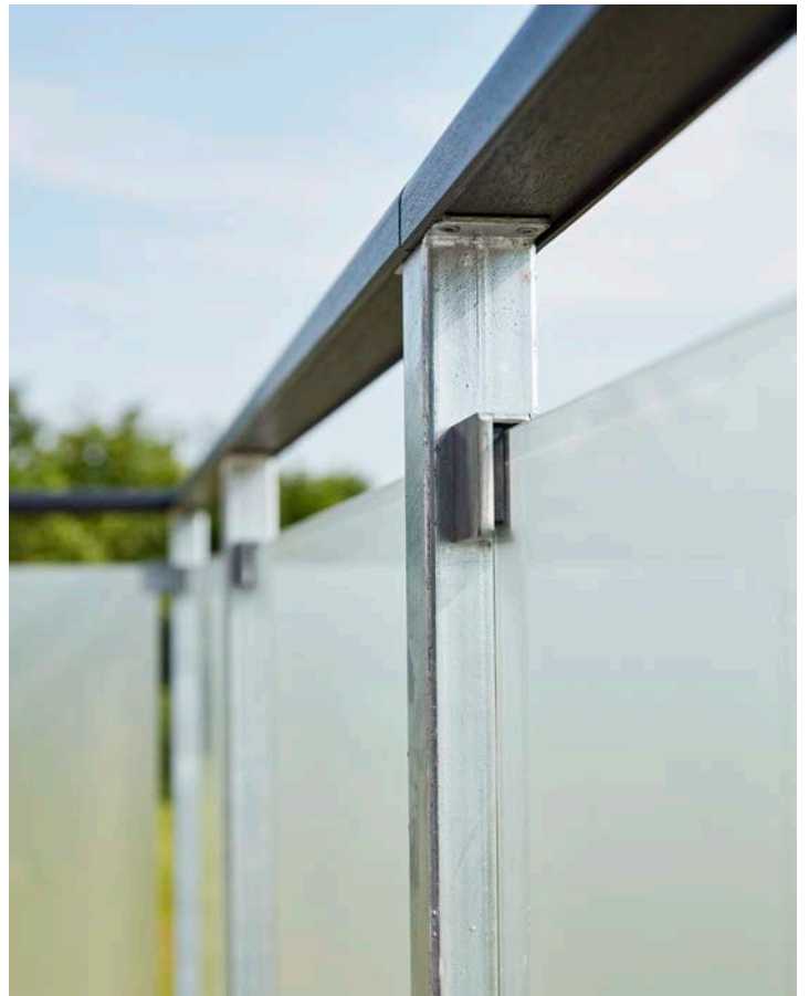
Stahlpfosten mit Fuß und Handlauf – Detail
